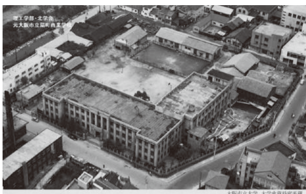
扇町にあった理工学部北学舎 左下 北野病院 右下 大阪YWCA会館
