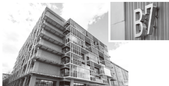
工学部新棟（B7棟）
