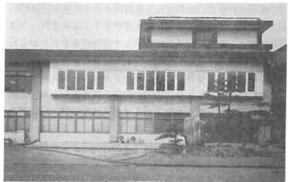
工学部創立40周年記念事業により設置された学術情報交流センターの外観東面
