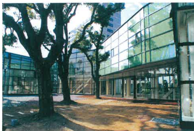
〔高原記念館(平成18年10月竣工)〕
